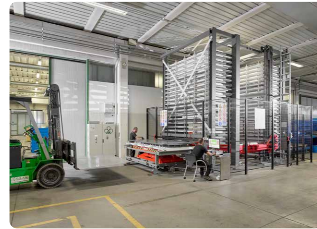
Magazzino automatico verticale per lamiera Steel Tower (sette siderurgico)
