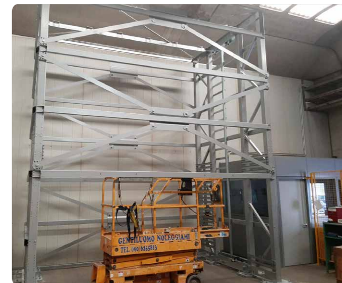
STRUTTURA ANTISISMICA RINFORZATA
