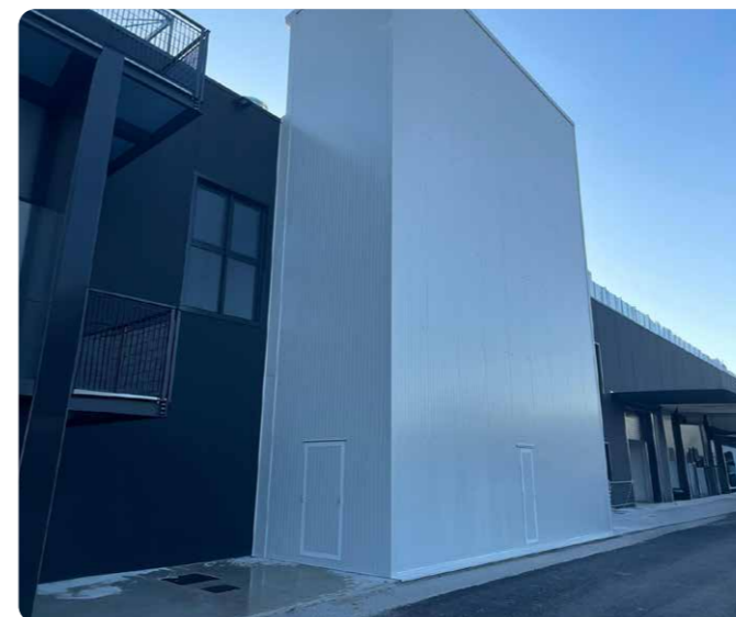
SOLUZIONE AUTOPORTANTE COIBENTATA DA ESTERNO
