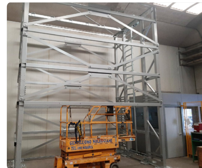
STRUCTURE ANTISISMIQUE RENFORCÉE
