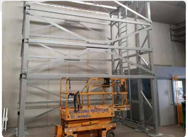
**ESTRUCTURA ANTISÍSMICA REFORZADA**
